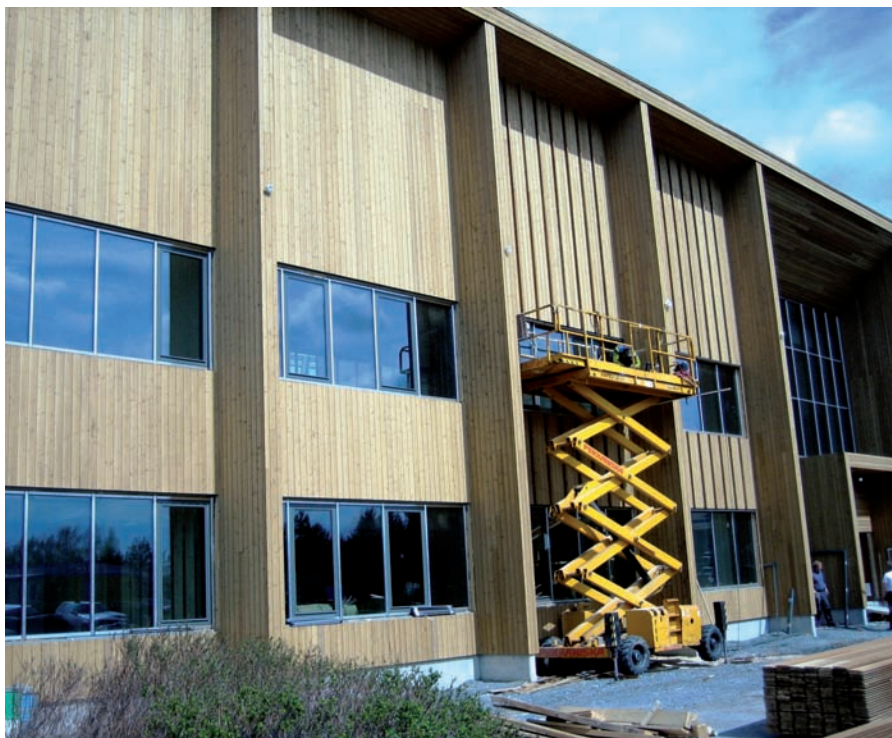
Lämpöpuu on oiva valinta kun halutaan kestävä mutta myös näyttävä ulkoverhous. Kuvassa Euroopan suurimman puu- ja huonekalualan kouluttajan Teak Oy teknologikeskuksen laajennusrakennuksen työmaa.
